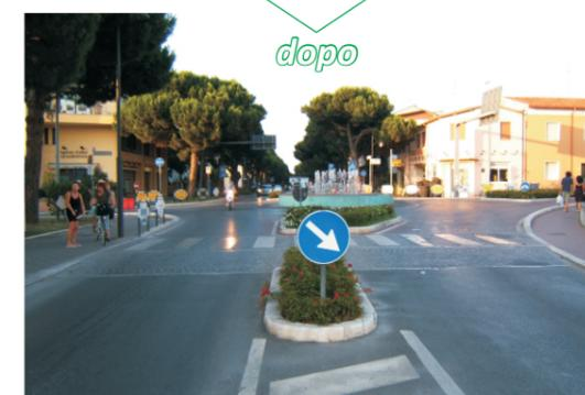
L'anello intorno alla città storica di Cesenatico a senso unico su tre corsie semaforizzate (nella foto sopra nell'anno 2000) è trasformato a doppio senso su due corsie con rotonde (nella foto sotto nel 2007): paradossalmente riducendo la sezione e le velocità di punta, è diminuito il tempo di viaggio
